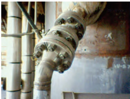
Этот двухдюймовый изоляционный кран модели CA-DRI класса ASME 300 легко справляется с устранением горячего использованного катализатора из регенератора.
