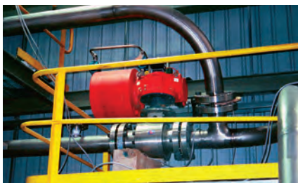
Этот 6-дюймовый выпускной клапан класса 900 находится в эксплуатации с 1999 года.
