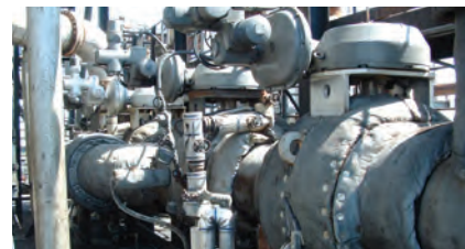
На этом нефтеперерабатывающем заводе на Среднем Западе США используются четыре 20-дюймовых шаровых крана класса ASME 300 компании для обслуживания паров, отводимых сверху колонны. Некоторые из них уже прослужили 10 лет и продолжают эффективно работать.
