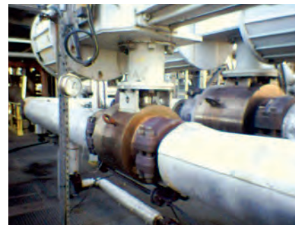
Эти 12- и 16-дюймовые шаровые краны с плавающим шаром установлены на спускной системе одного из европейских нефтеперерабатывающих заводов, ответственного за производство 115 000 баррелей в сутки.
