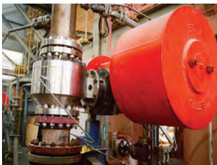
Этот 10-дюймовый разгрузочный клапан класса 300 был разработан с продувочными отверстиями по запросу клиента.
