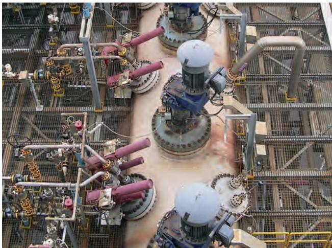
Крупный азиатский горнообработывающий комплекс сохраняет эксплуатационную надежность своих автоклавов с помощью шаровых клапанов для суровых условий. Патентованное покрытие является крайне важным компонентом, обеспечивающим надежность функционирования клапана.
