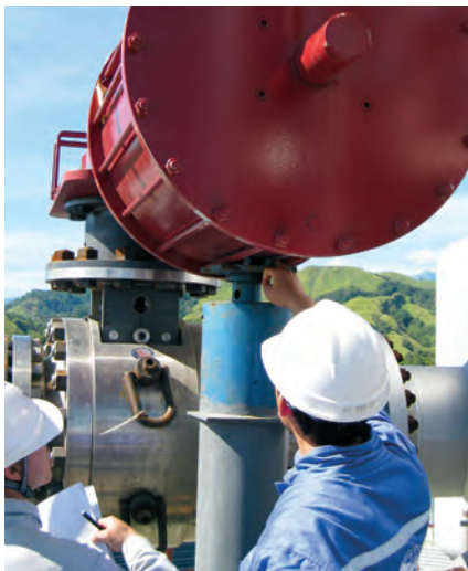
Полевой технический персонал находится на площадке во время запуска как автоклавной установки, так и трубопровода шлама в этом удаленном месте.
